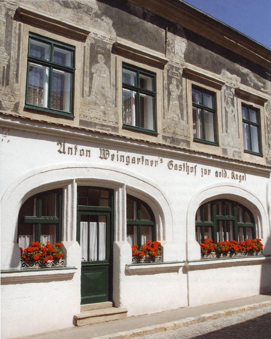
Sgraffito-Haus in der Bahnhofstraße
