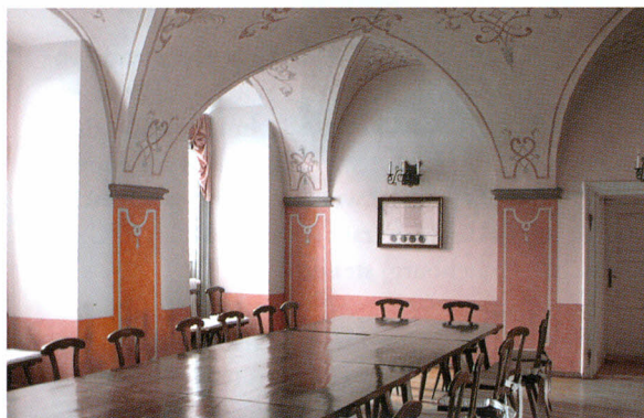
li.: Stuckrelief an der Decke des Gerichtssaales, re.: Gerichtssaal im Erd- geschoss des Nordtraktes
