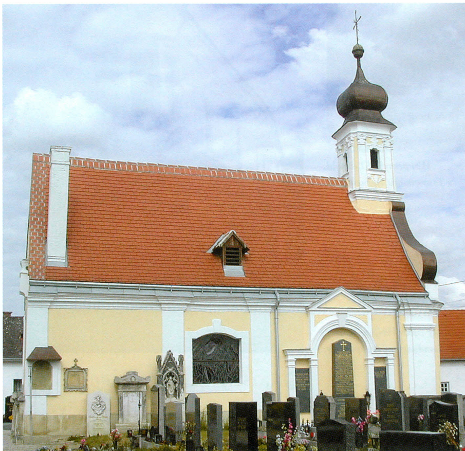
Die Friedhofskapelle, errichtet 1778/79, wurde nach dem Ersten Weltkrieg zur Kriegergedächtniskapelle umgestaltet und ist nunmehr eine Gedenkstätte für die in den beiden Weltkriegen gefallenen Langenloiser Soldaten.
