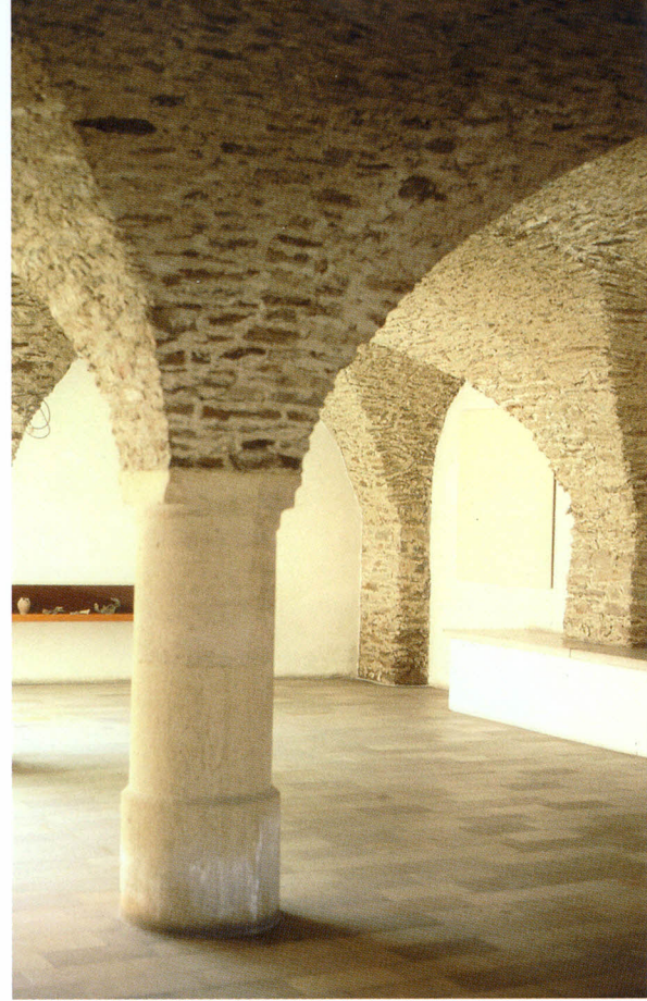
Ehemalige Gotikhalle mit Säulen und Gewölbe
